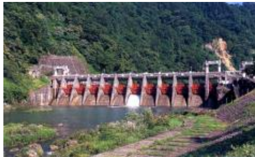
庄川用水合口ダム
